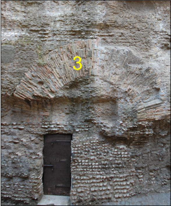
ARCO DI SCARICO IN LATERIZIO CON RICORSI DI BIPEDALI SOGGETTO A POLVERIZZAZIONE
