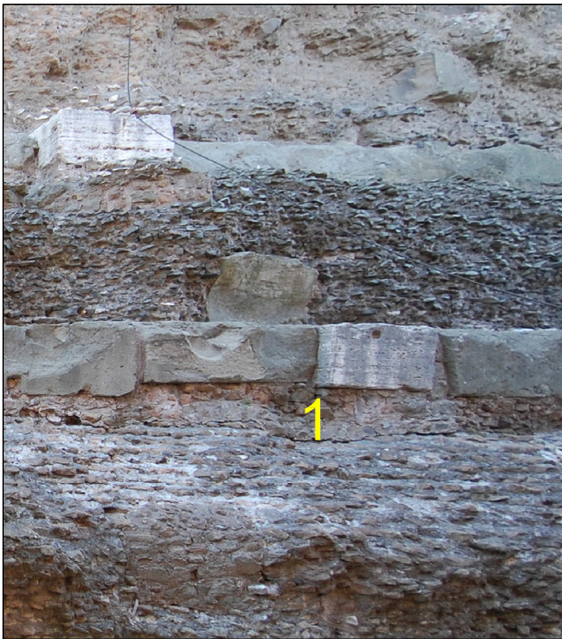
COLMAMENTO CON TUFI IRREGOLARI CON MALTA POZZOLANICA E CEMENTO
