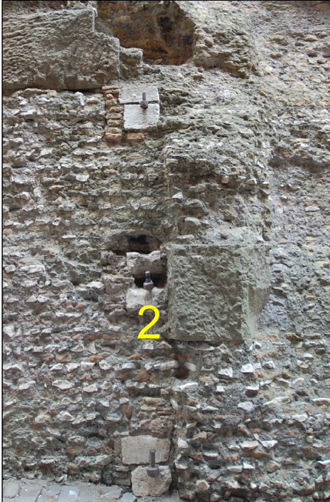
STRUTTURA MISTA CON BLOCCHI IRREGOLARI DI TUFO, SELCE E TRAVERTINO DISPOSTI A CORSI ORIZZONTALI TRACCE DI CERNIERE
